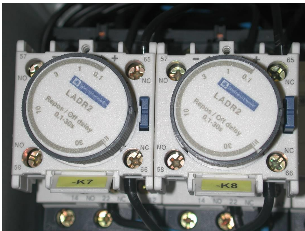
Fig. 15-5 Durée de commutation
