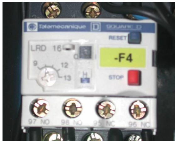
Fig. 15-4 Protection moteur
